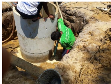
ภาพ 4 : แสดงการใช้ปล้องบ่อป้องกันการพังทลาย
